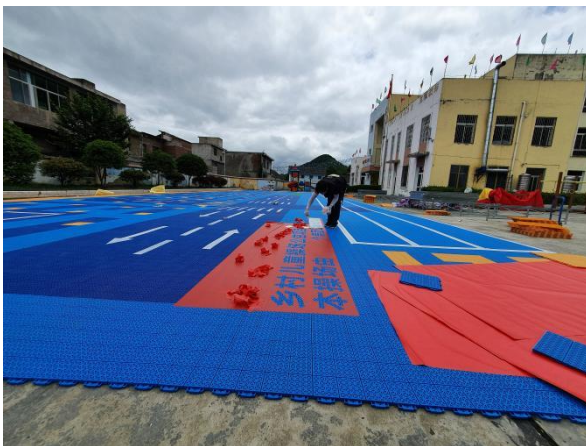
图：黔西市金兰镇中心幼儿园-场地铺设照片
