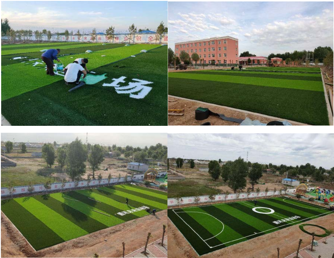
足球场地建设完成
