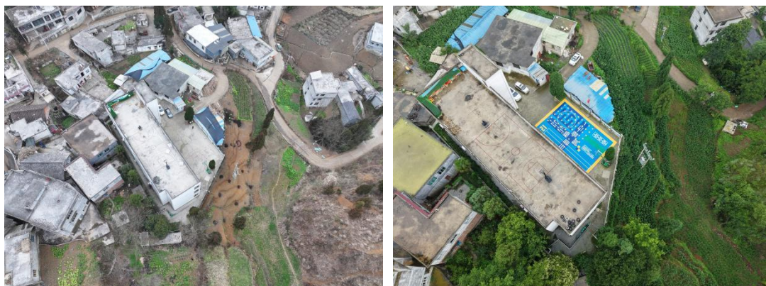
图：六盘水市钟山区保华镇双营幼儿园-铺设前后航拍图
