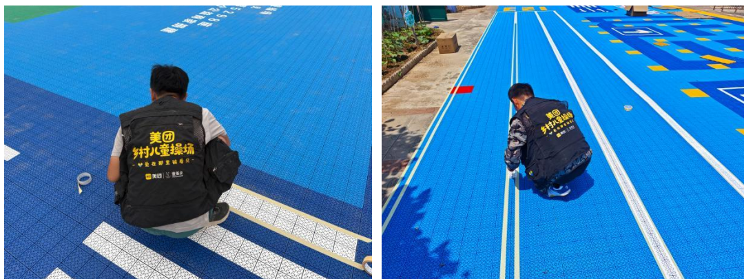
左：新乡县七里营镇第一中心幼儿园-场地铺设照片 右：信都区太子井乡龙石幼儿园-场地铺设照片
