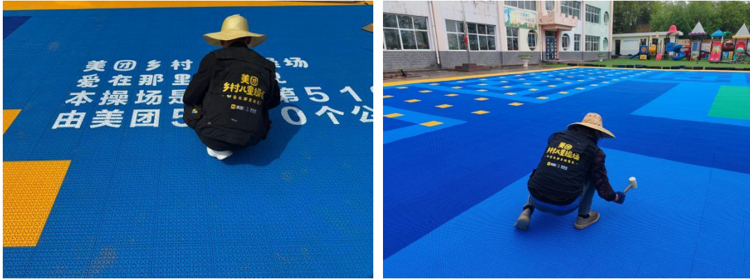
左：延津县石婆固镇社区幼儿园-场地铺设照片 右：临夏县尹集镇新兴小学附属幼儿园-场地铺设照片
