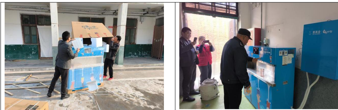
陕西泾阳县项目校设备安装照片
