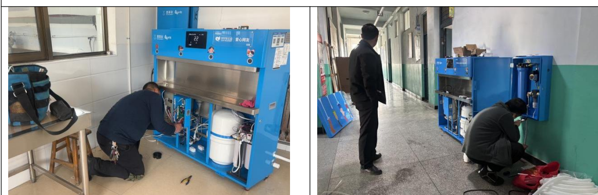
甘肃平凉市项目校设备安装照片
