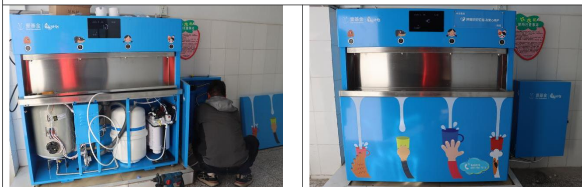
重庆武隆区项目校设备安装照片
