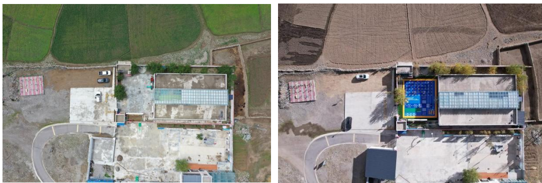
图：南木林县普当乡娘热村幼儿园-铺设前后航拍图
