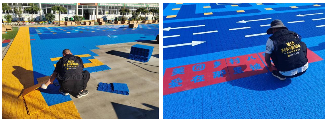
左：迁西县洒河桥镇中心幼儿园-场地铺设照片 右：伊宁县萨木于孜镇中心幼儿园-场地铺设照片
