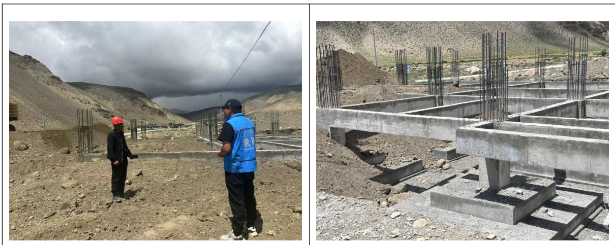
2025 年 8 月，由深圳市龙华区慈善会支持的定日县尼辖乡尼辖村幼儿园已完成基础验收，正开展回填工作。
