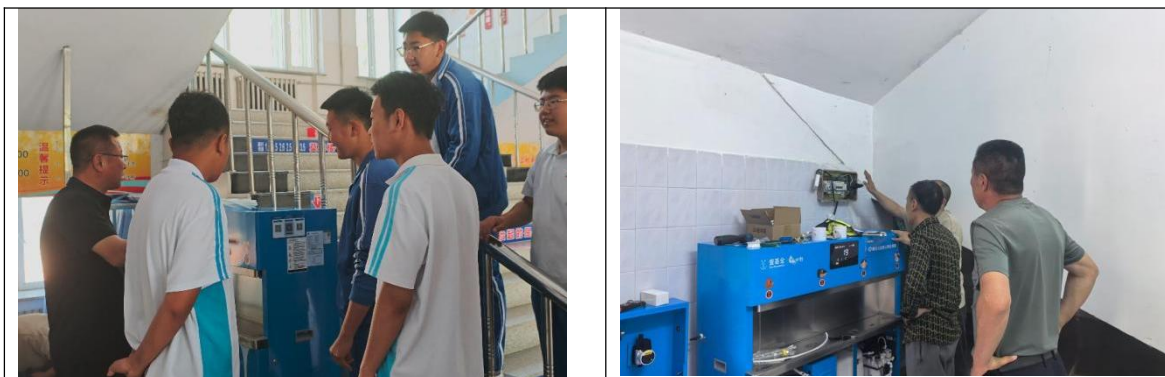
黑龙江肇源县项目校安装净水设备
