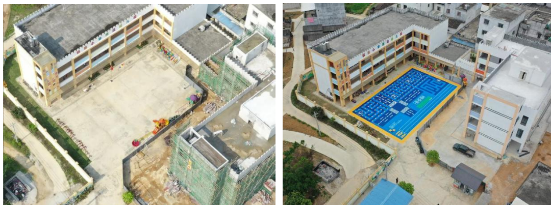
图：上林县白圩镇狮螺小学附属幼儿园-铺设前后航拍图
