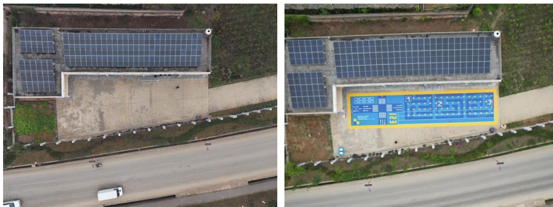
图：丘北县八道哨乡中心幼儿园-铺设前后航拍图
