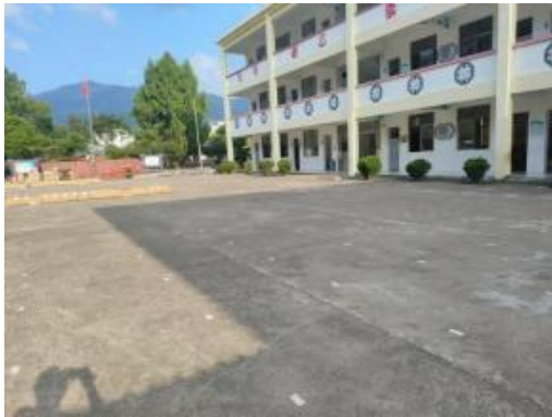
建设前的场地
