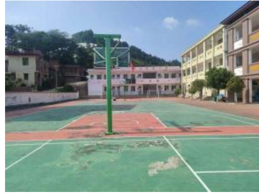
建设前的场地
