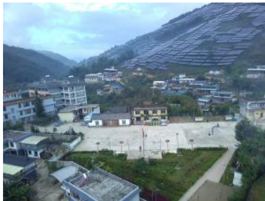
建设前的场地
