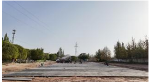
右图：项目校球场硬化完工
