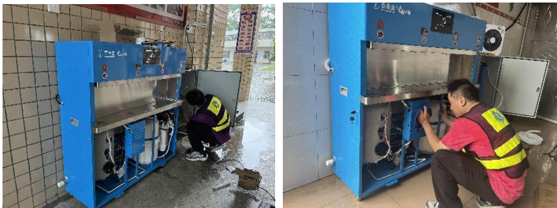
广西罗城仫佬族自治县项目校正安装设备
