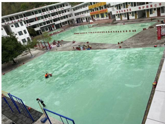
左图：施工现场
