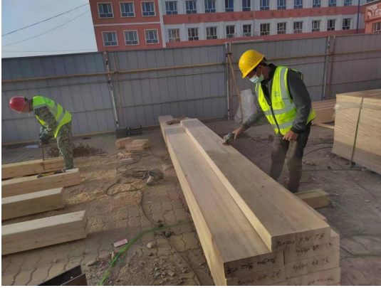
左图：施工现场
