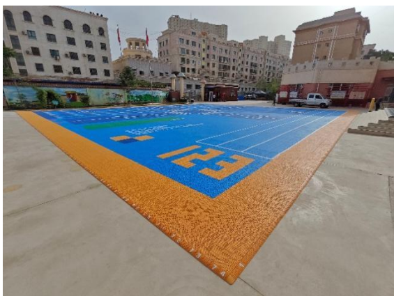
左：和田市团城幼儿园-铺设全景照片
