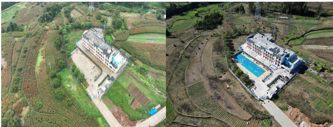
图: 隆阳区瓦窑镇老营幼儿园-铺设前后航拍图
