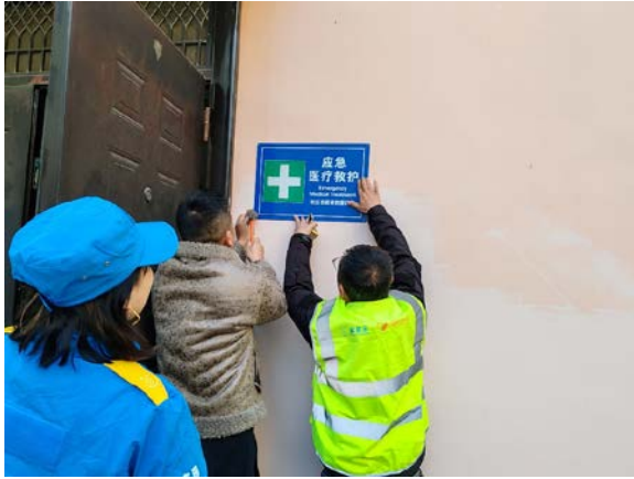
队员安装风险标识牌
