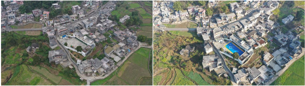
图：晴隆县光照镇中心幼儿园孟寨分园-铺设前后航拍图
