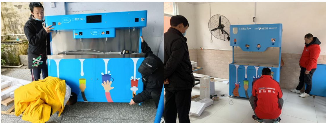
左图：重庆梁平区项目校安装设备
