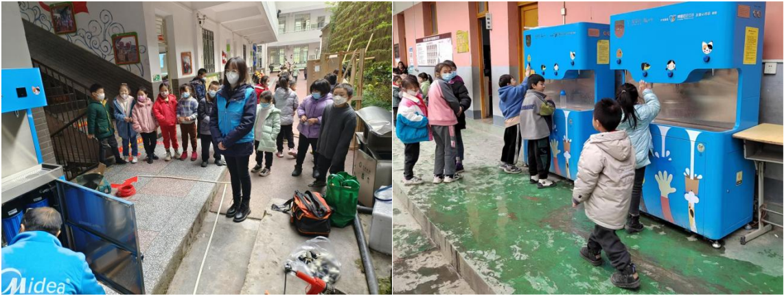
左图：重庆万州区项目校安装设备
