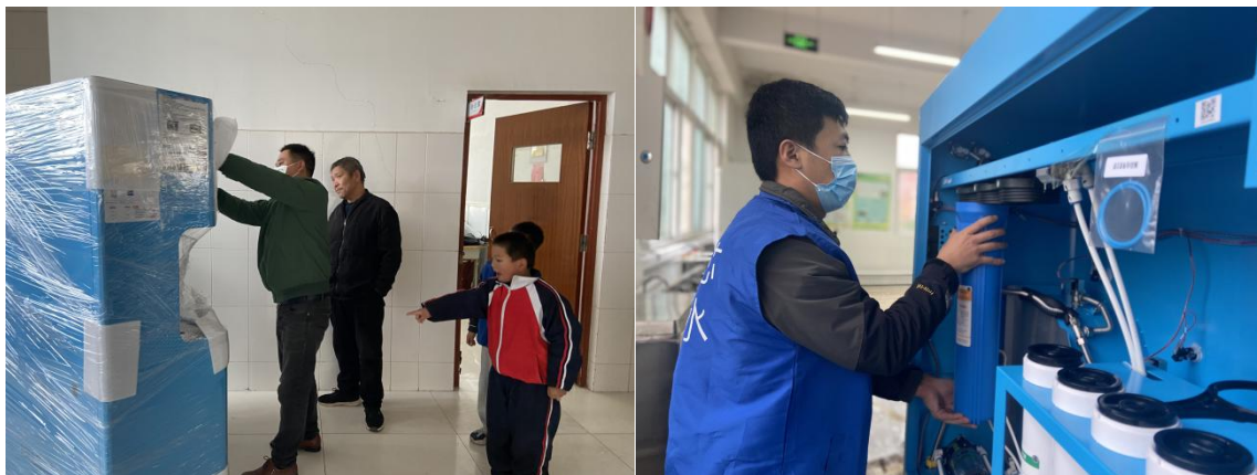
山东安丘县项目校正在安装设备
