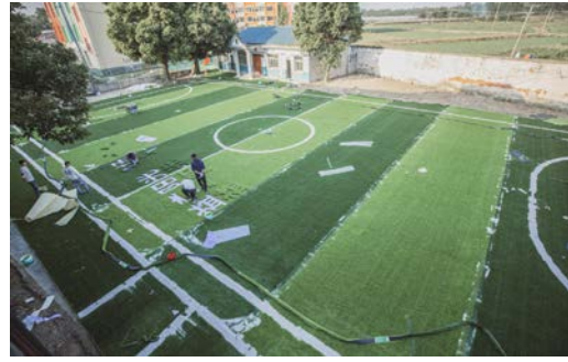
右图：安州永河小学足球场施工现场
