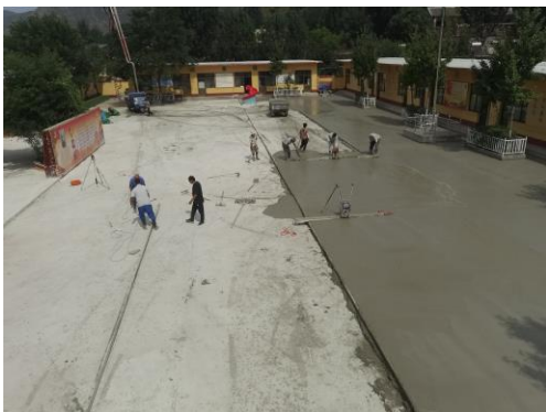
左图：岭后小学硬化施工现场
