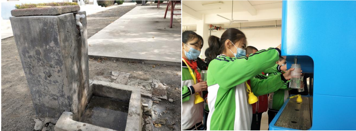
学校水源处与设备安装后使用的情况
