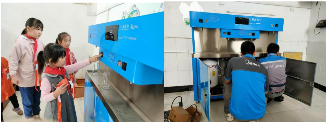
湖北鄂州市项目学校设备安装现场
