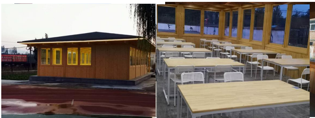
河北灵寿北庄完小木结构框架建设完成，学校家具已安装
