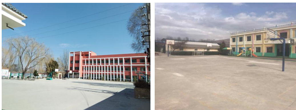
2020年5月20日，甘肃武山场地硬化完成
