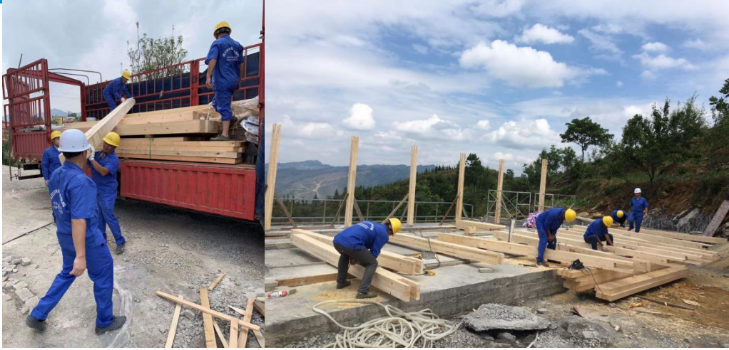
图为贵州普安高棉小学木结构框架建设进程
