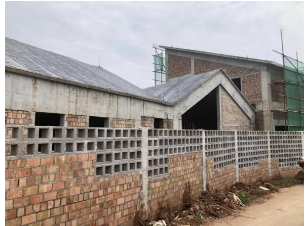
天全县大坪乡中心幼儿园围墙施工
