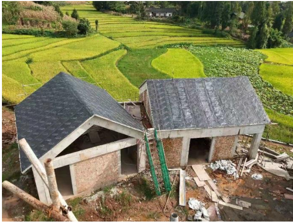
天全县大坪乡中心幼儿园屋面防水施工完成
