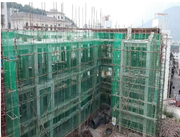
汉源县九襄镇枣林村幼儿园主体形象进度
