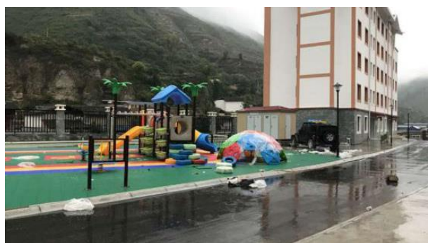
图 3. 运动汇游乐设施安装
