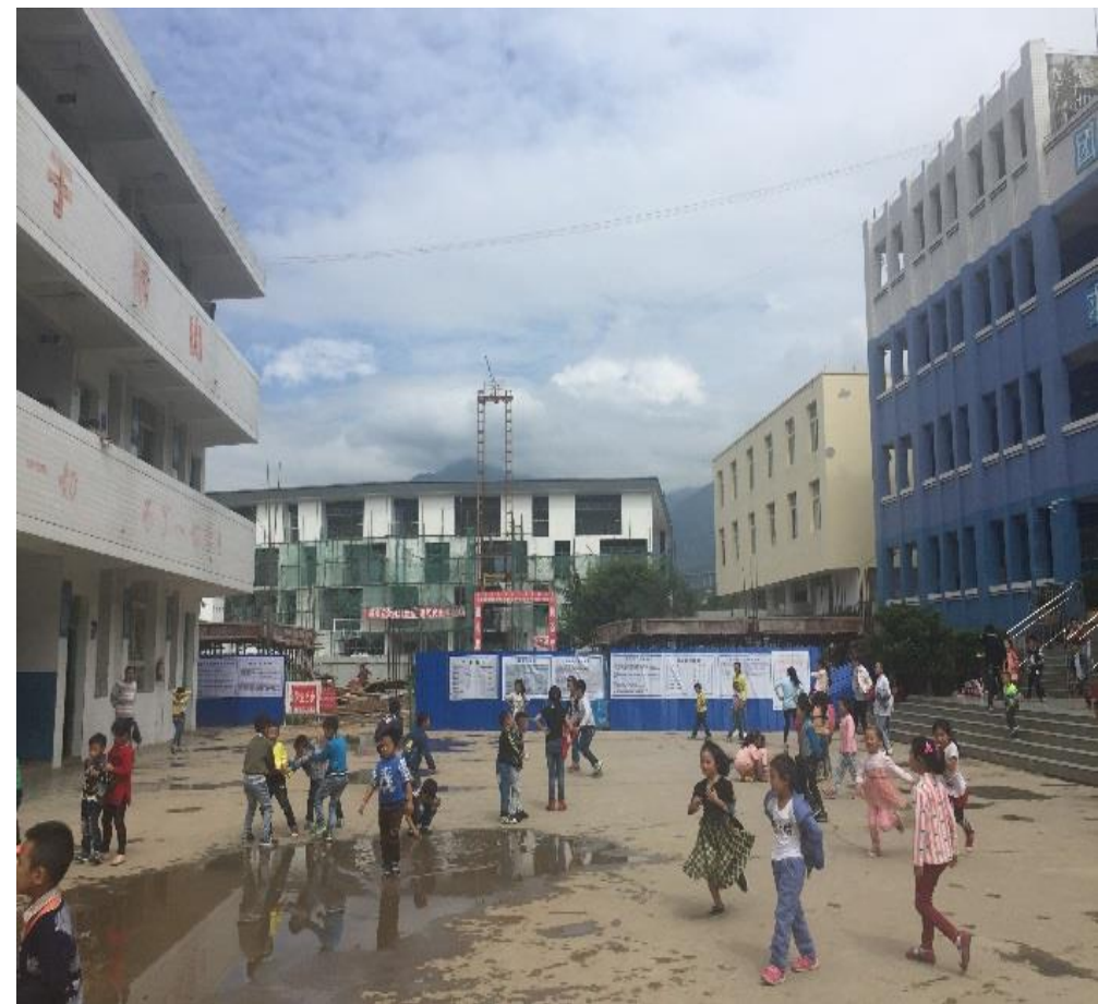
集贤幼儿园外墙施工
