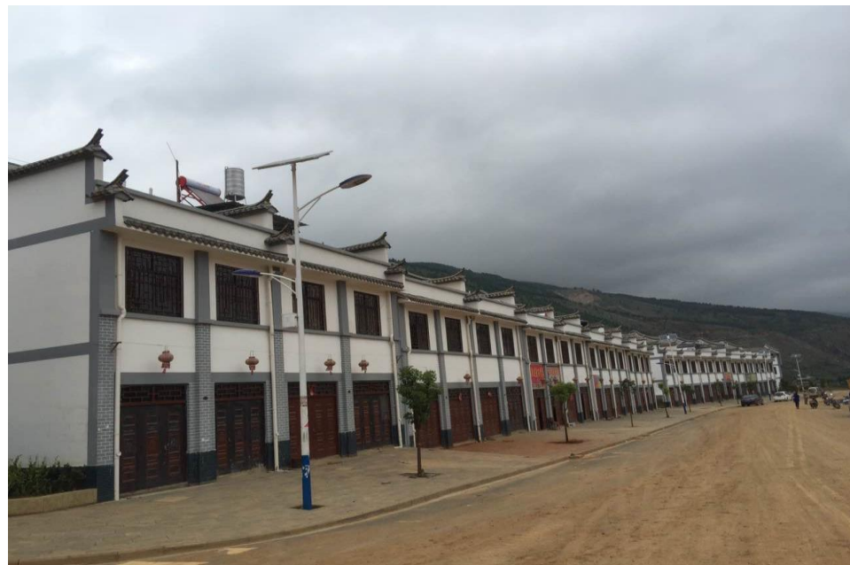
钢结构抗震农房会泽县以礼安置点
