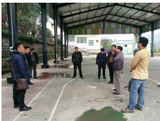
天全县乐英中心校避灾运动场顶棚项目竣工验收
