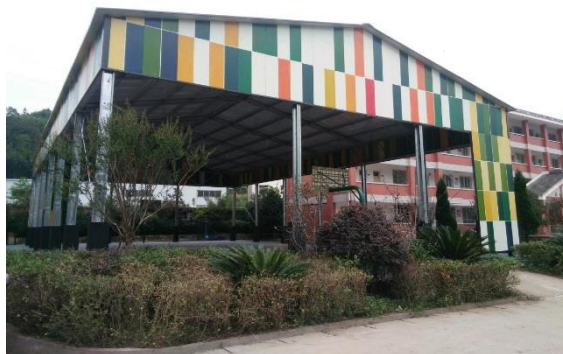
沙坪中心校避灾顶棚项目竣工
