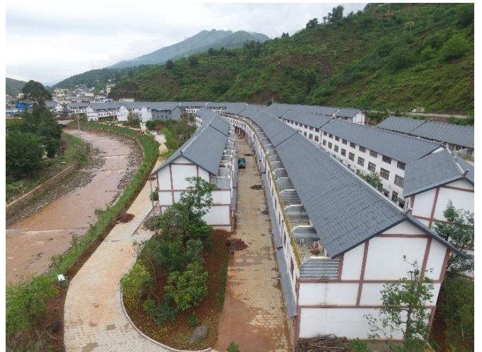
图为壹基金援建龙头山镇沙坝村钢结构抗震农房安置点
