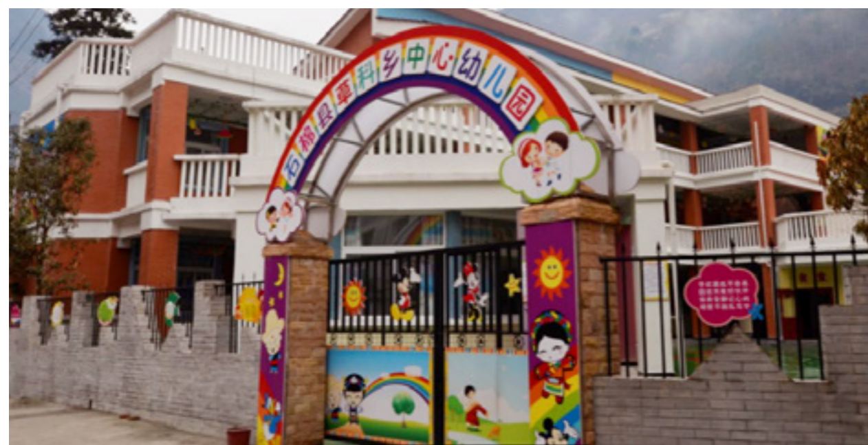
2016 年 7 月, 石棉县草科乡中心幼儿园竣工投入使用。 摄影 / 秦弦
