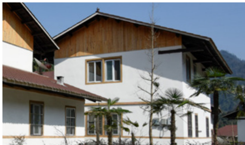
宝兴县大溪乡烟溪村钢结构抗震农房。 摄影 / 雷刚
