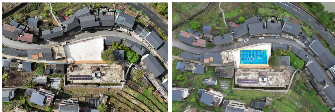
图: 福贡县马吉乡乔底幼儿园-铺设前后航拍图
