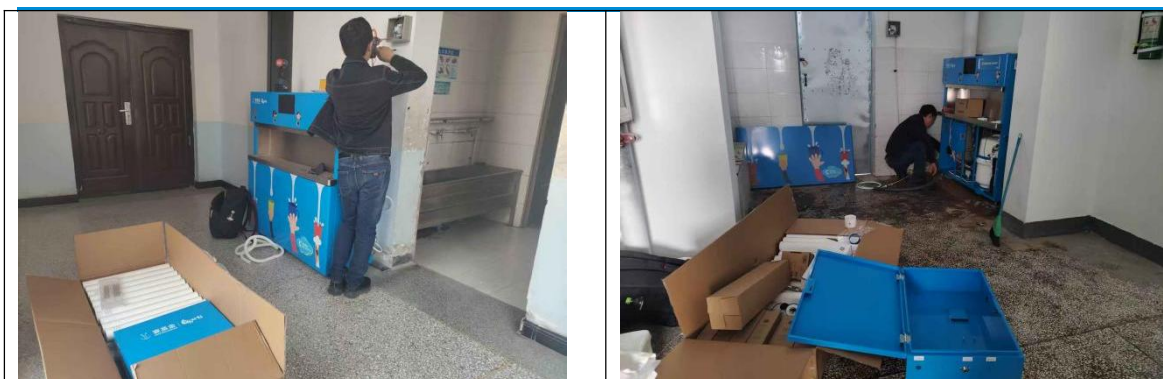
新疆第八师石河子市项目校设备安装照片
