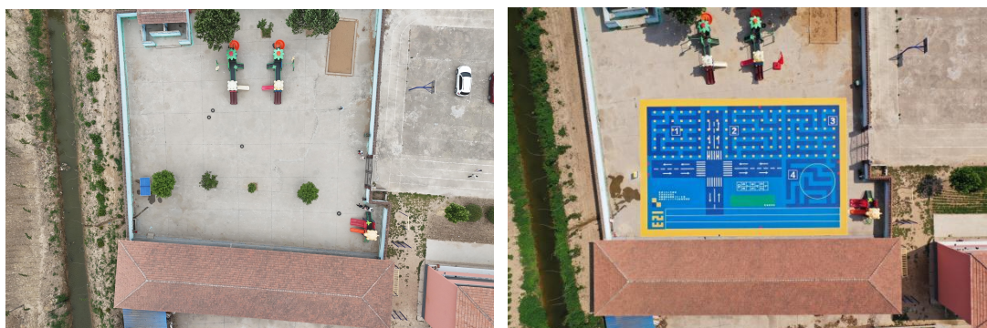
图：扶沟县练寺镇周桥小学附属幼儿园-铺设前后航拍图
