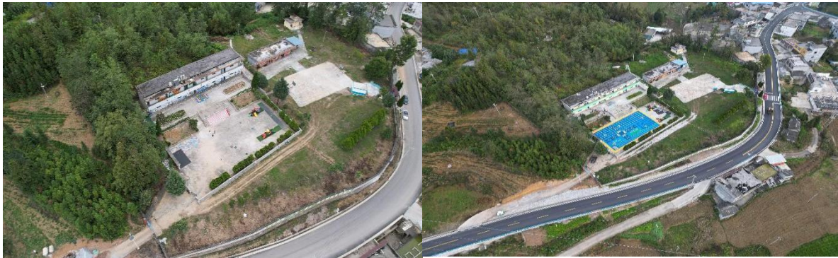
图: 安龙县普坪镇戈塘幼儿园大坝分园-铺设前后航拍图
