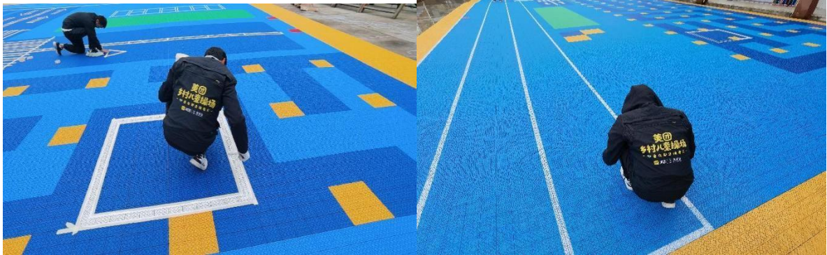
左图：开阳县双流镇三合幼儿园-场地施工照片 右图：正安县班竹镇上坝幼儿园-场地施工照片
