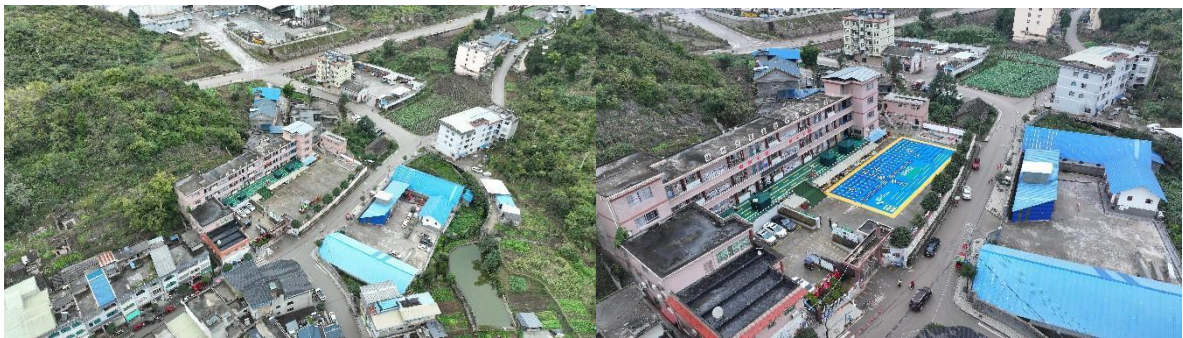
图: 播州区茅栗镇中心幼儿园-铺设前后航拍图
