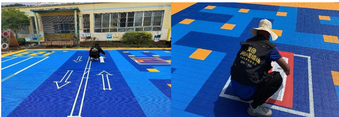
左图：正安县班竹镇旦坪幼儿园-场地安装照片 右图：清镇市新店镇东风幼儿园马鞍分园-场地安装照片
