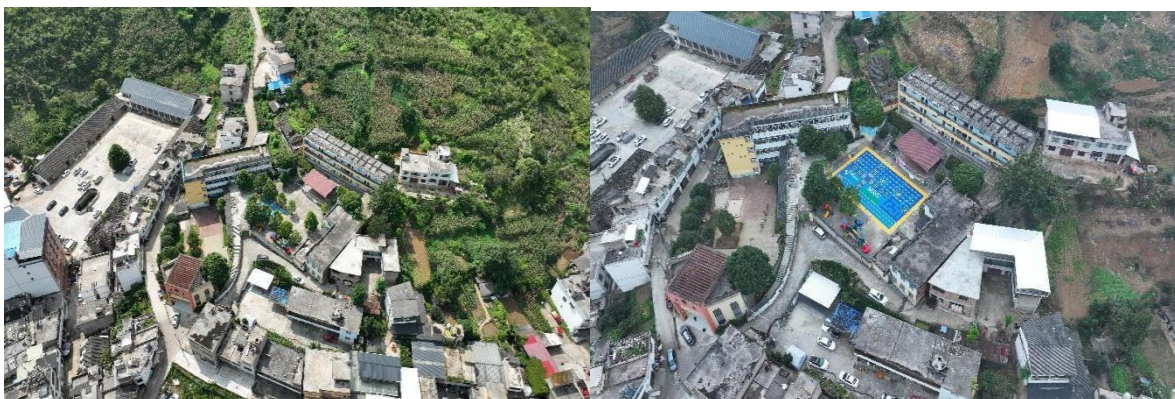
图：开阳县花梨镇幼儿园-铺设前后航拍图
