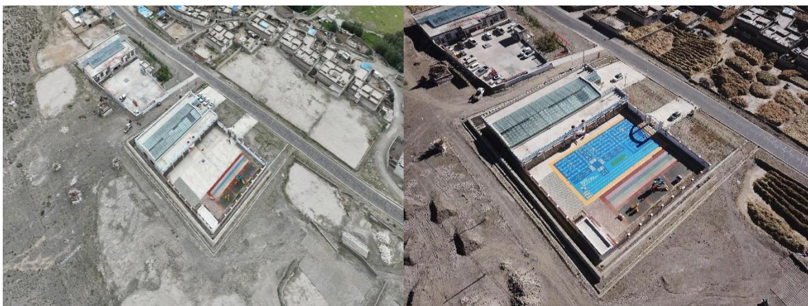
图：萨迦县麻布加乡白拉村幼儿园-铺设前后航拍图
