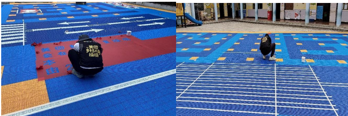
左图：播州区石板镇乐意村幼儿园-场地施工照片 右图：湄潭县新南镇凉进幼儿园-场地施工照片
