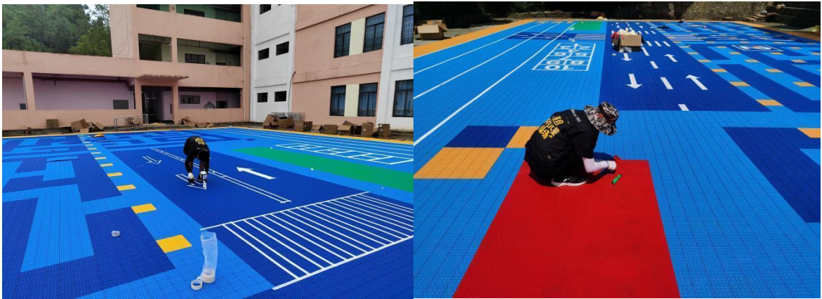
左图：安顺市普定县马场镇第三幼儿园-场地施工 右图：金沙县木孔镇湾子幼儿园-场地施工
