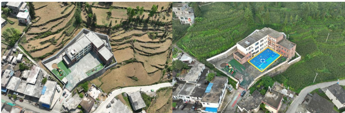
图：六盘水市水城区花戛乡海子幼儿园-铺设航拍
