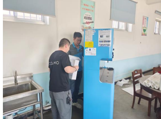
右：甘肃省宁县净水设备安装现场
