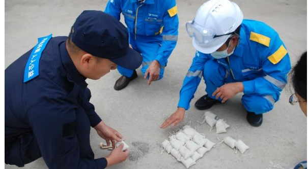
防洪堤坝搭建
