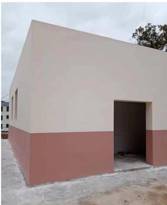
石阡县花桥镇北坪小学校厕所改造
