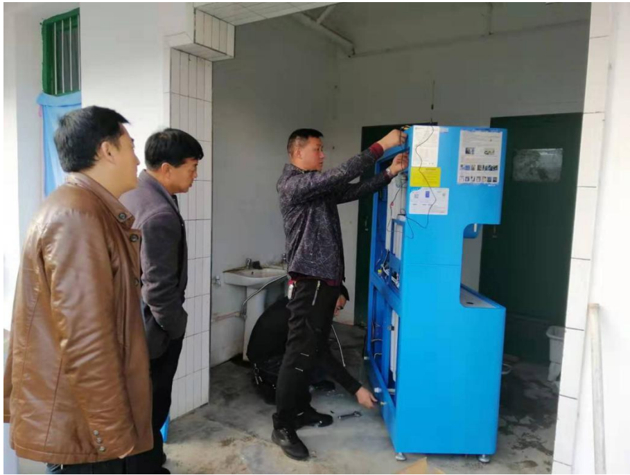
11月11日陕西扶风县 设备到货，陆续开展安装
