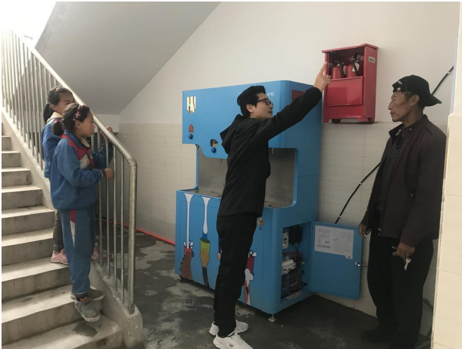
11月四川喜德县13所项目学校20台净水设备正在陆续安装中
