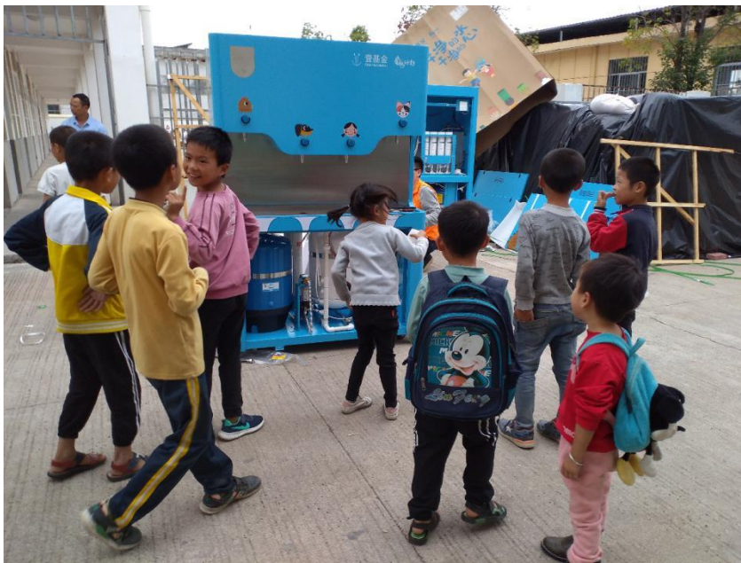
一群小朋友围着一台正在安装的净水机叽叽喳喳的议论着
